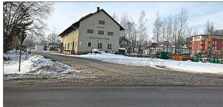
Die derzeitige Sicht auf das Gelände von der Brückenstraße her. Mit dem SWS-Projekt wird das alte Lagerhaus endgültig abgerissen.
